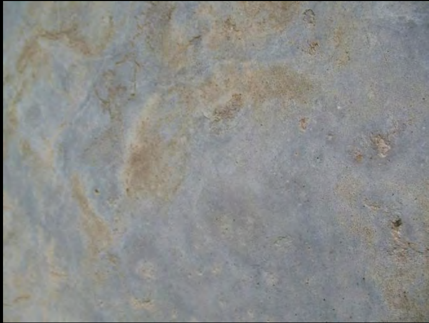
Particolare dell'intonaco della cappella 25
