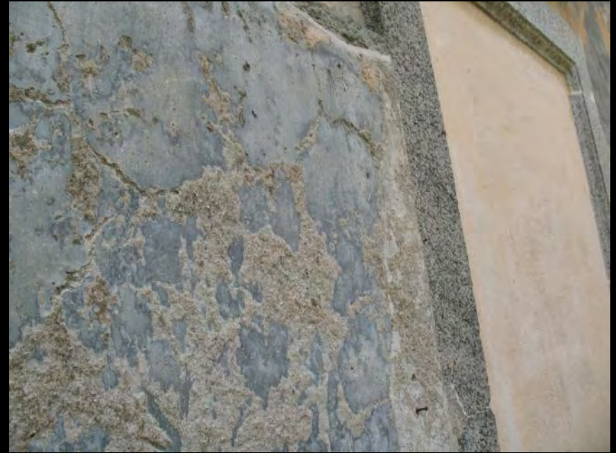
Particolare dell'intonaco della cappella 13
